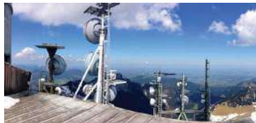
ภาพแสดงตัวอย่างสายสัญญาณและอุปกรณ์ประกอบสำหรับระบบส่งสัญญาณ (Antenna and RF Components for Content Transmission System)
